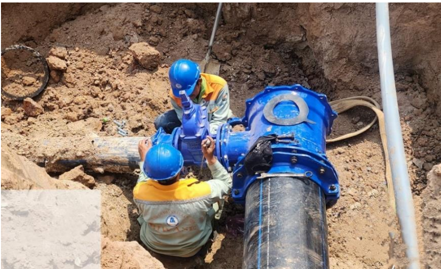
Tuyến ống trục Bàu Bàng – Dầu Tiếng sẽ hoàn thành và đưa vào sử dụng tháng 6/2023
