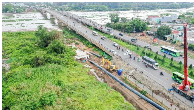
Thi công tuyến ống nước thô D1200mm vượt sông Vàm
