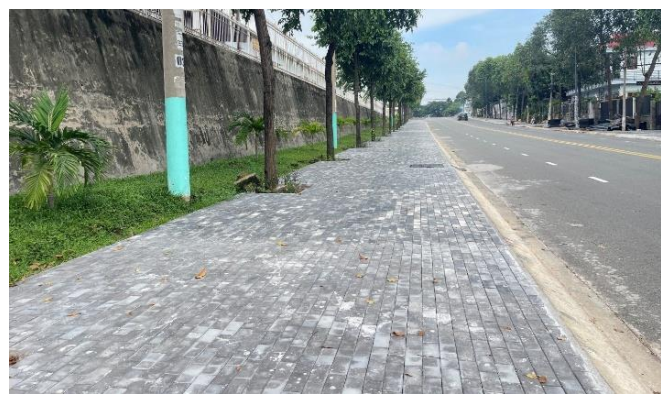
Công trình chỉnh trang đô thị tuyến đường Hồ Văn Cống, P.Chánh Hiệp sử dụng gạch BIWASE - Con Voi Bình Dương
