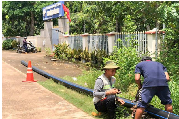
Thi công tuyến ống dẫn nước sạch trên địa bàn ấp Suối Dzui, xã La Ngà, tỉnh Đồng Nai
