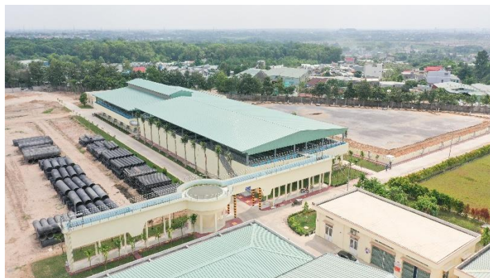
Nhà máy nước Dĩ An sẽ được nâng công suất lên 150.000m 3 /ngày đêm
