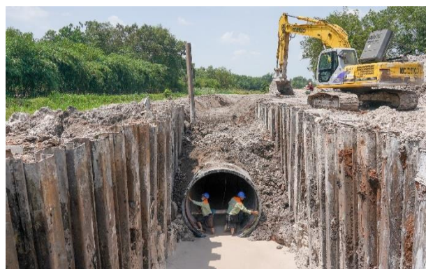
Đường ống nước thô D2400 tự chảy do BIWELCO lắp đặt.
