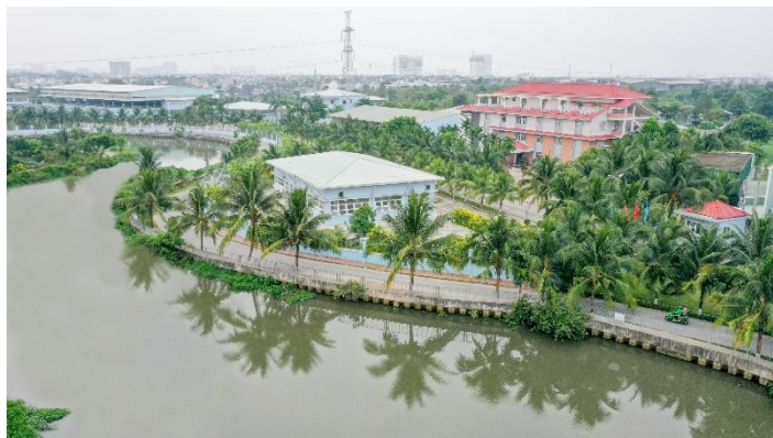
Từ nguồn vốn tài trợ của World Bank, tỉnh Bình Dương bổ sung thêm hệ thống thu gom nước thải sinh hoạt đến các vùng lõi mà dự án trước đây chưa bao phủ. (quang cảnh Nhà máy Xử lý nước thải Thuận An)
