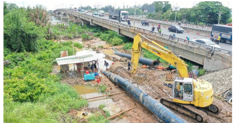
Thi công ngầm băng qua sông Vàm Cỏ tuyến ống nước thô D1200
