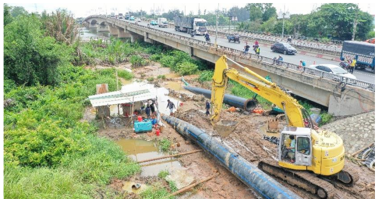
Thi công tuyến ống nước thô D1200 vượt sông Vàm Cỏ
