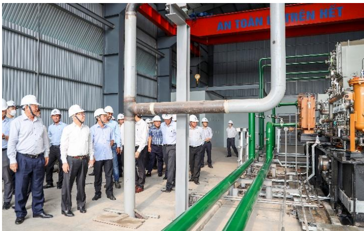
Lãnh đạo tỉnh Bình Dương đến tham quan, đánh giá cao tổ hợp đốt rác thu hồi nhiệt phát điện do BIWASE thiết kế, lắp đặt
