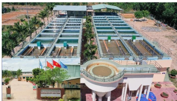
BIWASE Bình Phước có công suất cấp nước 30.000m 3 /ngày đêm.
