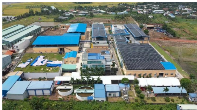
Nhà máy nước Nhị Thành – Giai đoạn 3 công suất 120.000m 3 /ngày đêm
