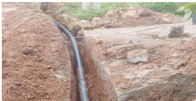
Tuyến ống cấp nước trên địa bàn ấp Phú Tân, xã Thống Nhất, Tỉnh Đồng Nai được thi công lắp mới phục vụ cho người dân trên địa bàn.
