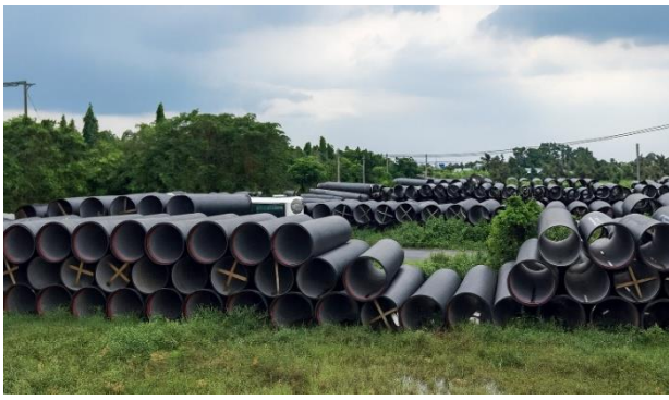
Bãi tập kết ống gang D1200mm của BIWASE - Long An sẵn sàng chờ thi công.
