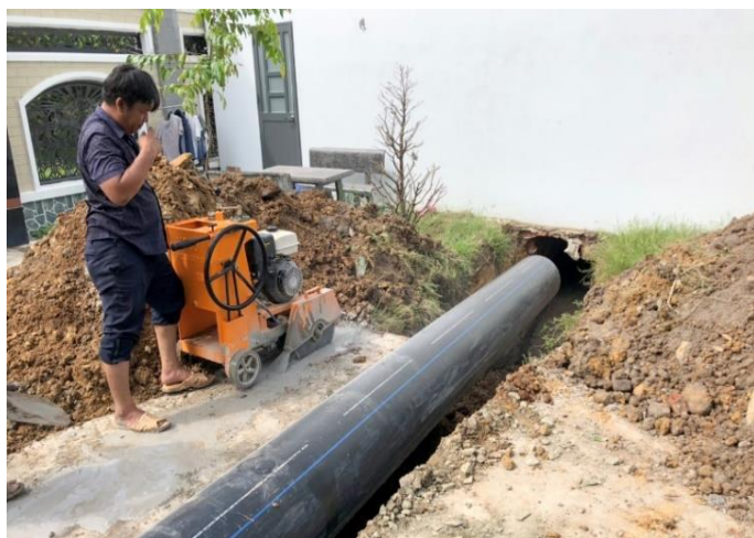
Người dân tạo thuận lợi cho đơn vị thi công lắp đặt đường ống ( xuyên qua nền nhà) để sớm có nước sạch sử dụng
