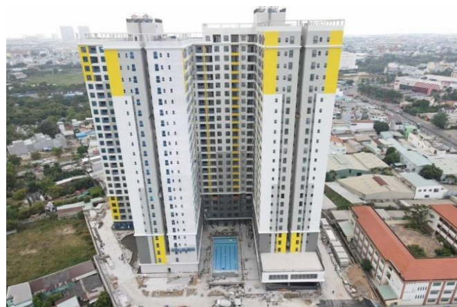
Chung cư cao tầng ven QL1K, phường Đông Hòa, Tp. Dĩ An
