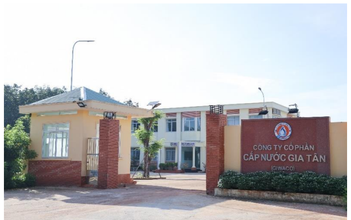
Nhà máy nước Gia Tân tăng 100% công suất và phát triển mạnh lưới chuyên tải đến nhiều huyện thị của tỉnh Đồng Nai.
