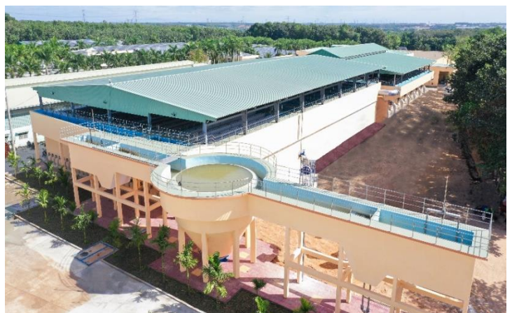
Nhà máy nước Tân Hiệp giai đoạn 3 công suất tăng thêm 100.000m 3 /ngày đêm đáp ứng nhu cầu phát triển của tỉnh
