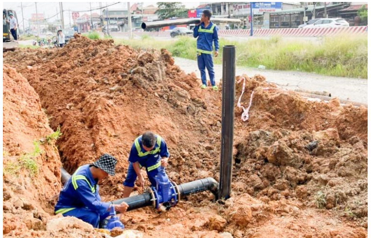
Di dời hệ thống cấp nước trên Đại lộ Bình Dương
