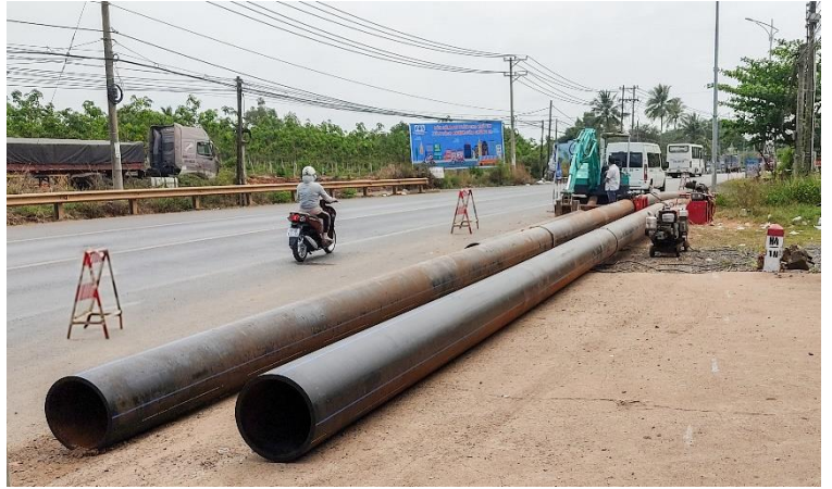
Công nghệ khoan ngầm phát triển đường ống ven QL 1A, huyện Thống Nhất, tỉnh Đồng Nai
